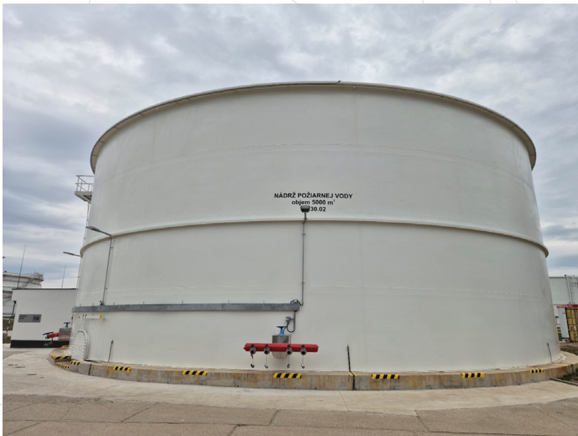
Obr.: Nová nádrž požiarnej vody objemu 5 000 m 3 v PS 4 Tupá.
