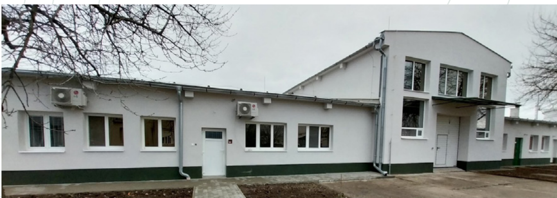
Obr.: V rámci rekonštrukcie objektu 080 - 100 Sklad MTZ v PS 4 Tupá bola obnovená strecha, fasáda a okná.
