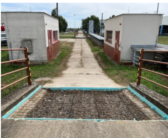
Obr.: Fotografie z priebehu rekonštrukcie nábehovej časti mostov v areáli PS 1 Budkovce.
