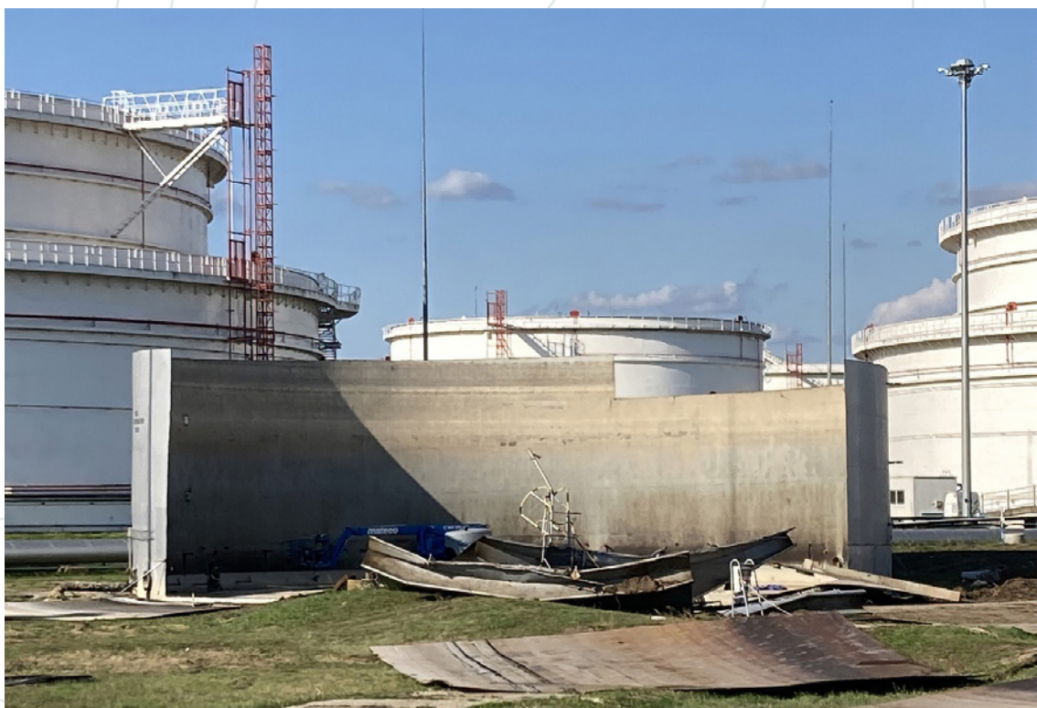
Obr.: Demontáž starej nádrže požiarnej vody.
