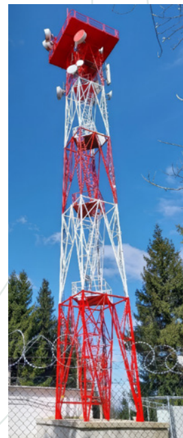
Obr.: V rámci rekonštrukcie objektov armatúrnych šácht na trase ropovodu boli obnovené strešné krytiny s príslušenstvom a fasády jednotlivých vybraných armatúrnych šácht a v rámci rekonštrukcie stožiarov RR bodov bolo na jednotlivých vybraných stožiaroch vykonané dostuženie ocelevej konštrukcie a obnova náterového systému, ktorý zároveň slúži ako denné letecké prekážkové značenie – na snímke stožiar RR bodu v lokalite Detvianska Huta.
