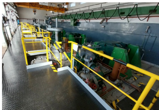
Obr.: Zrekonštruovaná podlaha čerpacej stanice ropy č. 221 v PS 4 Tupá.
