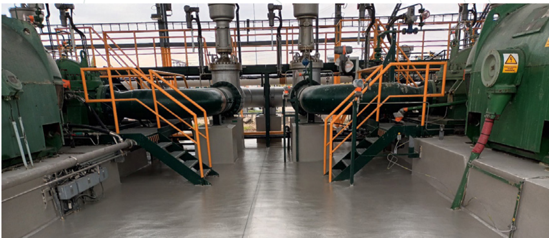
Obr.: V rámci IA č. 52401 - Rekonštrukcia stáčacích plôch v ČS 221 a oprava oporných pätiiek v PS 5 Bučany bola zrekonštruovaná aj podlaha čerpacej stanice ropy č. 221 v PS 5 Bučany.
