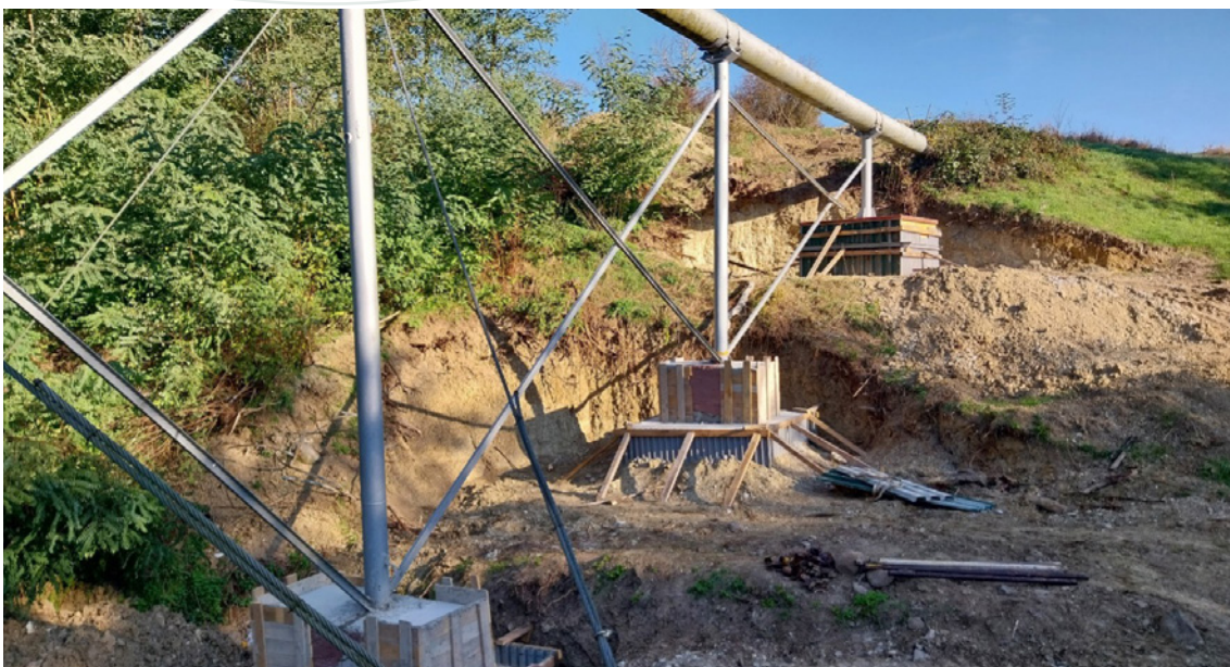
Obr.: Fotografia z priebehu rekonštrukcie nadzemného úseku Ďurkovce na trase ropovodu.
