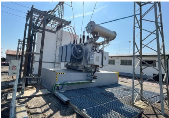
Obr.: Záchytné jímky transformátorov T101 a T102 v PS 1 Budkovce po rekonštrukcii.
