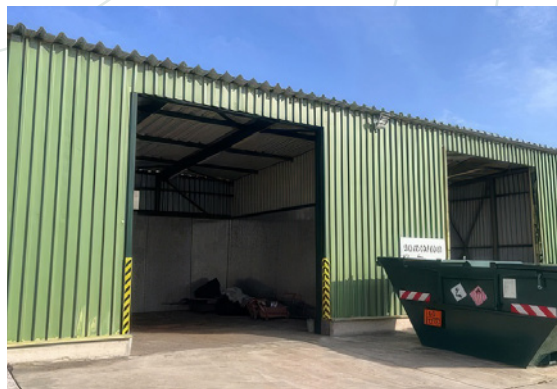
Obr.: Umývací box na čistiace elementy (tzv. ježky) v PS 1 Budkovce.
