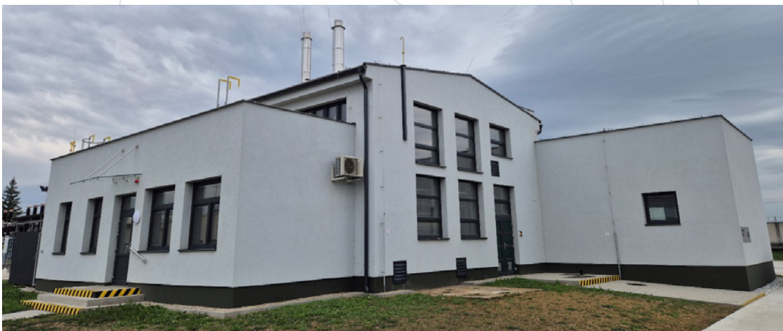
Obr.: Zrekonštruované priestory v areáli PS 4 Tupá pre pracovníkov Oddelenia diaľkovodov a katódovej ochrany.
