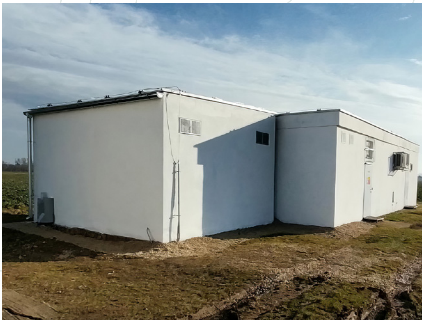
Obr.: V rámci rekonštrukcie objektov armatúrnych šácht na trase ropovodu boli obnovené strešné krytiny s príslušenstvom a fasády jednotlivých vybraných armatúrnych šácht a v rámci rekonštrukcie stožiarov RR bodov bolo na jednotlivých vybraných stožiaroch vykonané dostuženie ocelevej konštrukcie a obnova náterového systému, ktorý zároveň slúži ako denné letecké prekážkové značenie – na snímke stožiar RR bodu v lokalite Detvianska Huta.
