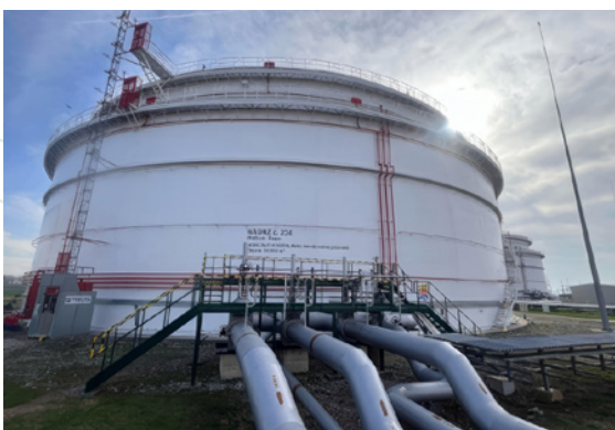
Obr.: Nádrž ropy č. N234 v PS 1 Budkovce po obnovení náteru.
