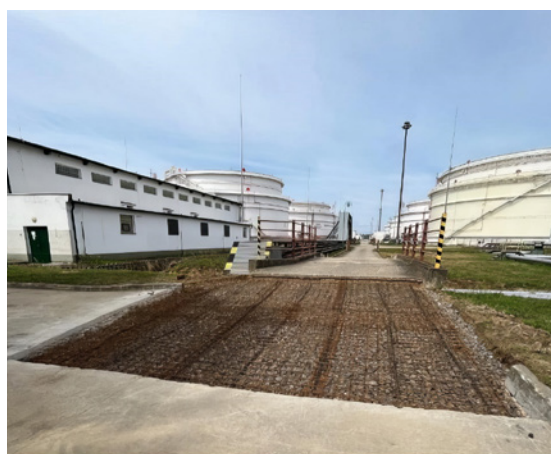
Obr.: Fotografie z priebehu rekonštrukcie nábehovej časti mostov v areáli PS 1 Budkovce.
