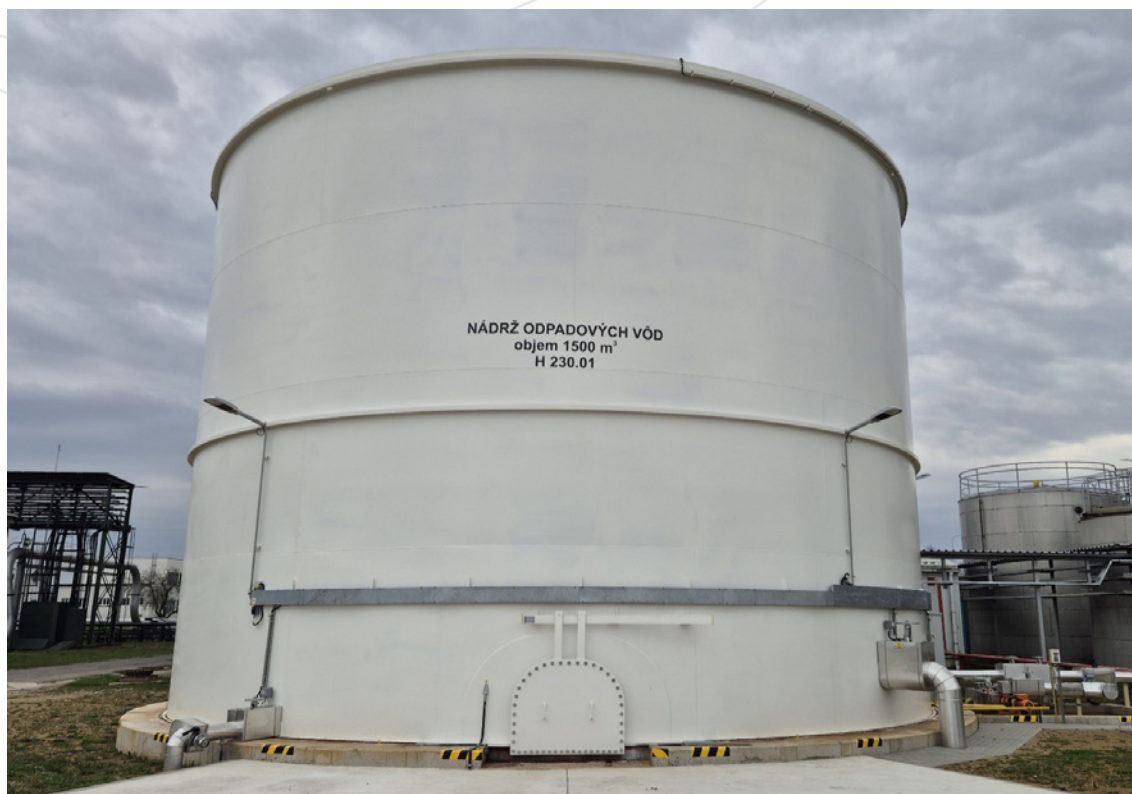
Obr.: Nová nádrž odpadových vôd objemu 1 500 m 3 v PS 4 Tupá.
